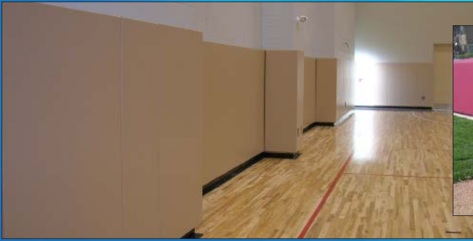
GYMNASIUM WALL PADDING
